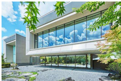
郡山モノリス （福島県郡山市）
